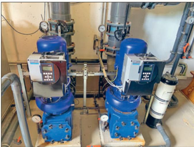
Bei den neu installierten Umwälzpumpen, welche modulierend je nach Anzahl der Badegäste betrieben werden können, rechnen wir mit einer Einsparung von ca. 30 %, somit ca. 15.000 kWh Elektroenergie.
