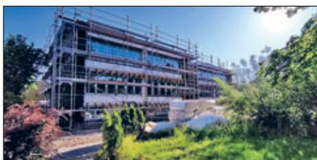
Die energetische Sanierung des Hortgebäudes gestaltet sich seit Beginn der Maßnahme schwierig. Mittlerweile sind die Rohbauarbeiten vollständig abgeschlossen, die neuen Fenster sind bis auf die Treppenhausverglasung eingebaut. Derzeit erfolgt die Montage der Außenraffstore, sodass anschließend die Arbeiten an der Fassadenverkleidung fortgesetzt werden können. Auch die Dachdeckerleistungen sollen im Juni fertiggestellt werden.
