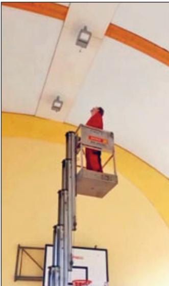
Auch in der Auerbacher Turnhalle wurde Ende März die Innenbeleuchtung erneuert. 10 Stück 184W-LED-Leuchten ersetzen nunmehr die alten 400W-Strahler. So werden jetzt in jeder Stunde, in der die Beleuchtung angeschaltet ist, 2,16 kWh gespart. Das entspricht 1 Euro/h. Wir sehen hier ein Sparpotential von 800 bis 1.000 Euro.
