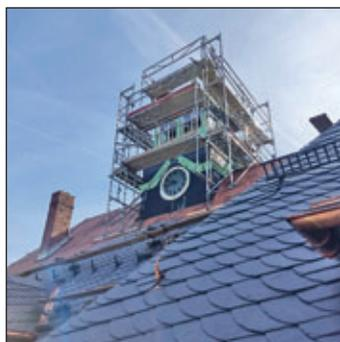
Die Dacheindeckung am Rathaus Meinersdorf schreitet voran. Zwischenzeitlich ist auch der Turm eingerüstet. Dort erfolgen eine neue Eindeckung und die Instandsetzung der Kupferverblechung, welche nicht vollständig ausgetauscht wird. Die Dachklempnerarbeiten sind in den letzten Zügen.
