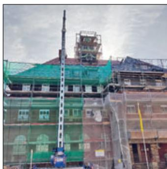
Dachgeschoss ist bereits erfolgt. Im Mai erfolgt nun das Aufmaß zum Austausch der Fenster im 1. Obergeschoss. Im Erdgeschoss und im Bereich der Treppenhäuser findet eine Aufarbeitung der vorhandenen Fenster statt, welche ebenfalls im Mai beginnen wird.
